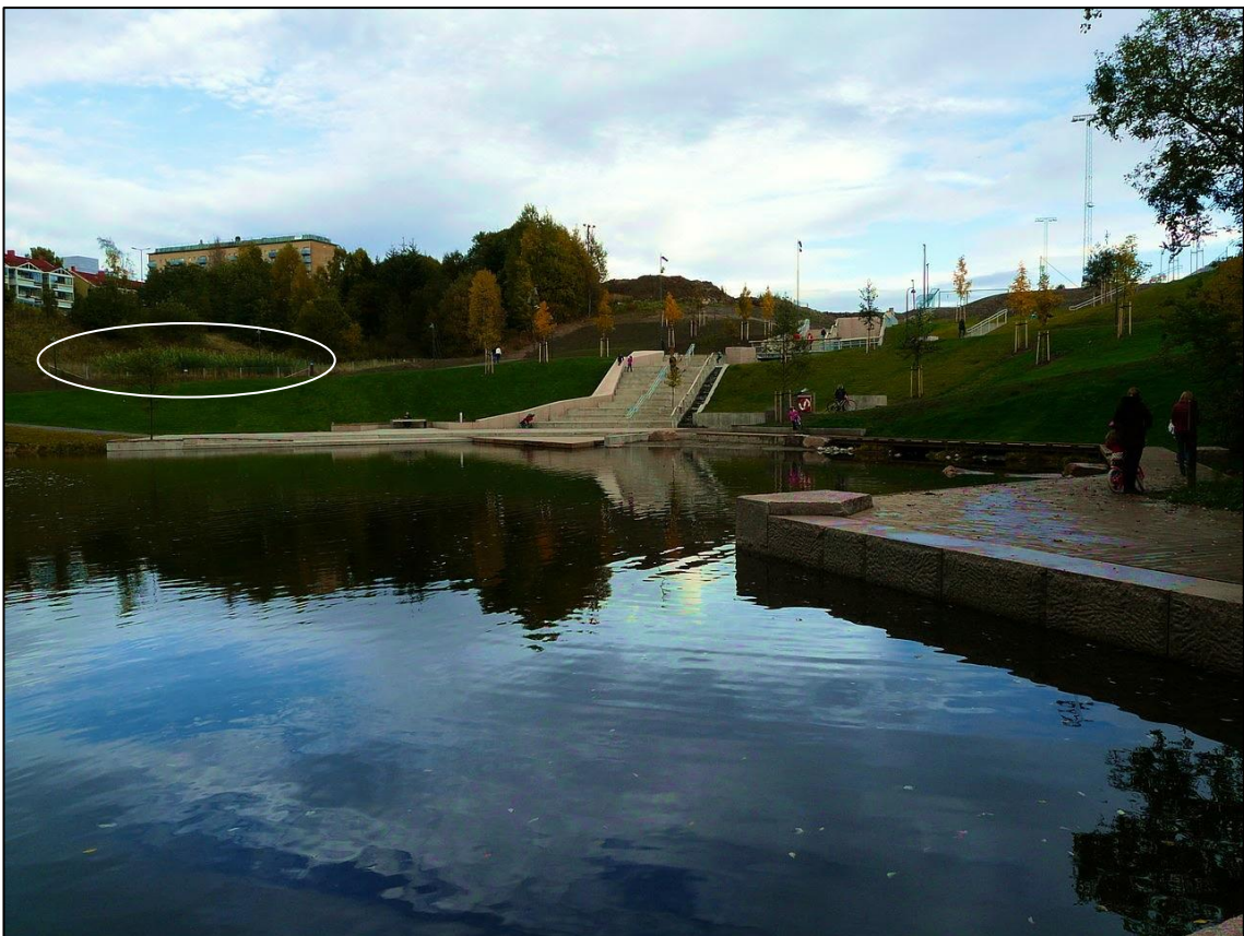
Figur 2.1: Groruddammen i Grorudparken, med område brukt til fytosanering.
